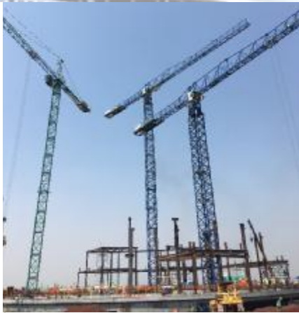
Desplante de la Torre de Control
